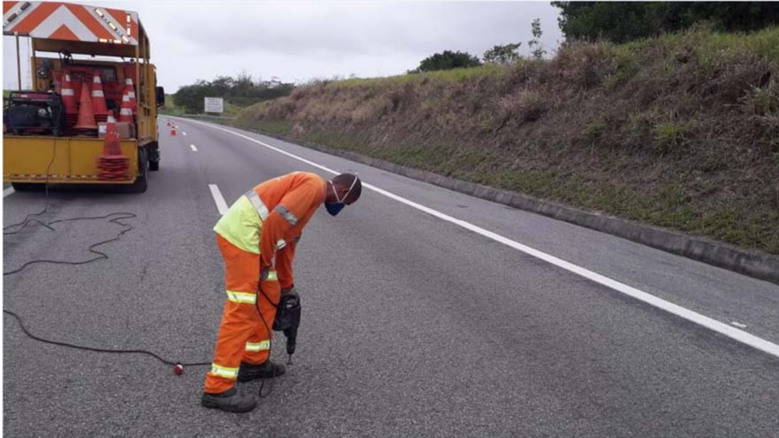
FOTO 07 - Implantação de Tachas - Km 43+000 Norte - F1
