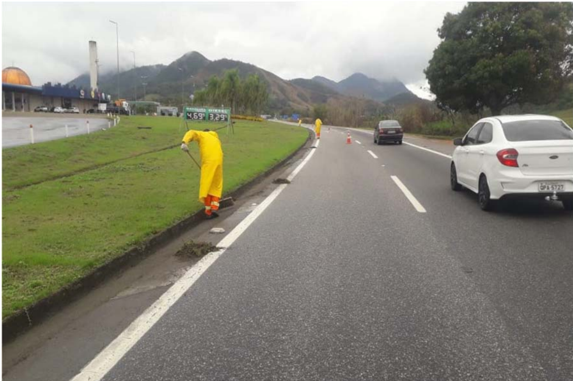
FOTO 16 – Limpeza de sarjeta - Km 23+000 Sul – F1
