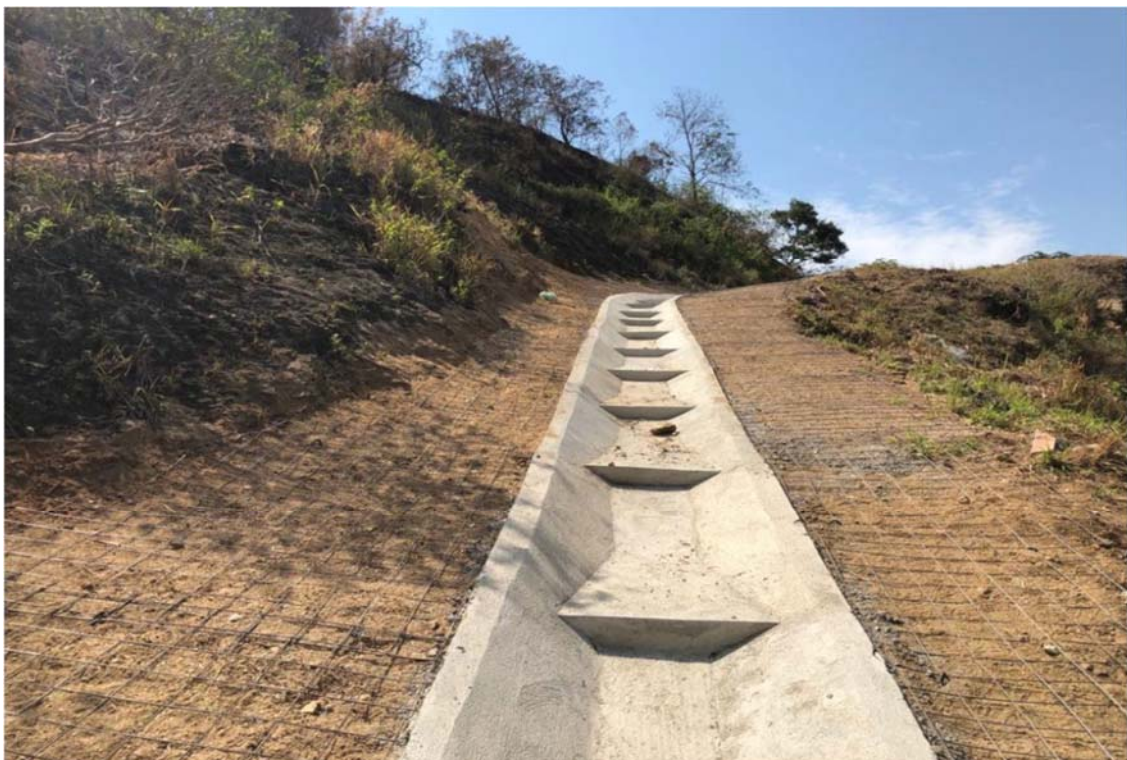
FOTO 19 – Drenagem Talude Km 15,7 – F3
