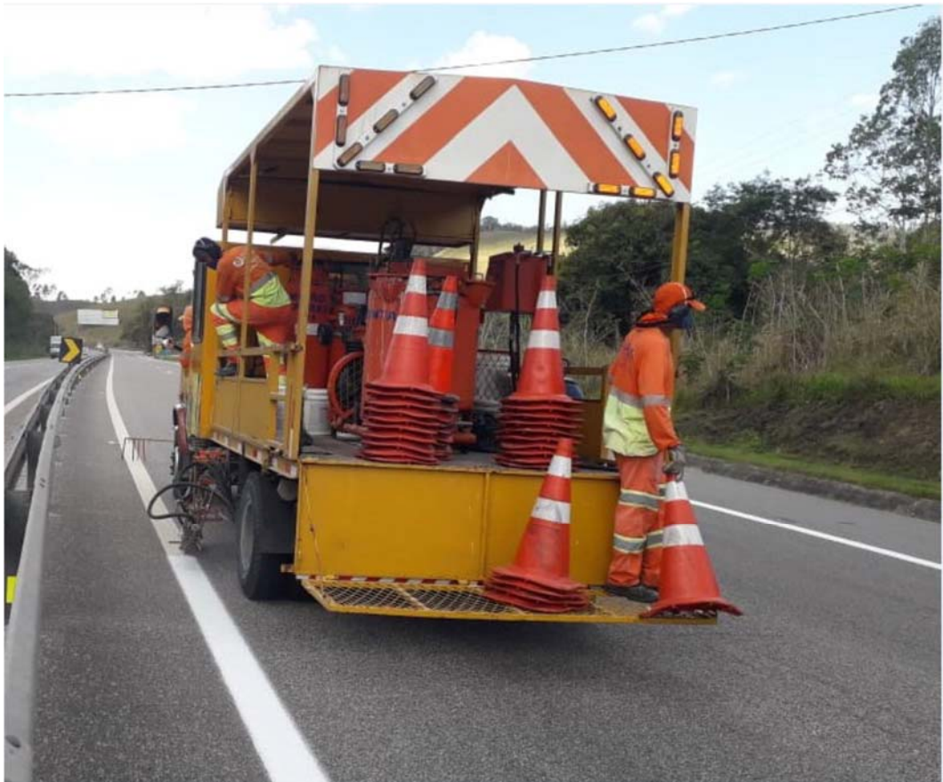
FOTO 02 – Pintura de faixas - KM 20+500 Norte – F2
