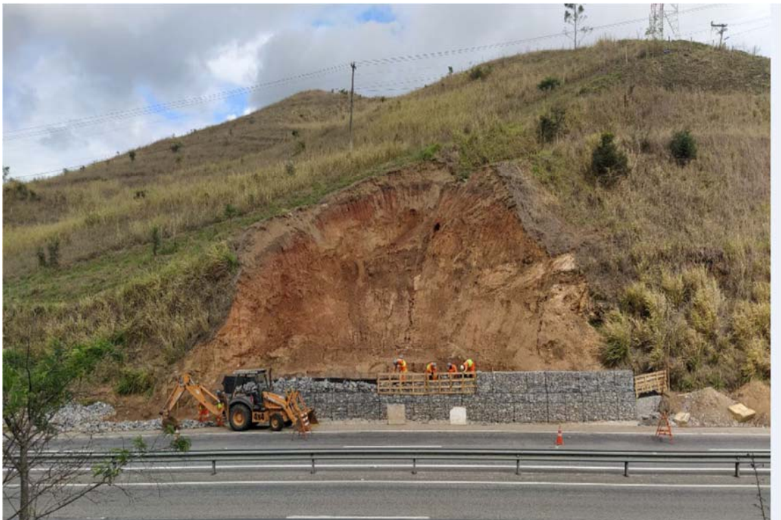
FOTO 23 – Obra de recuperação do Talude Km 9+760 – F2
