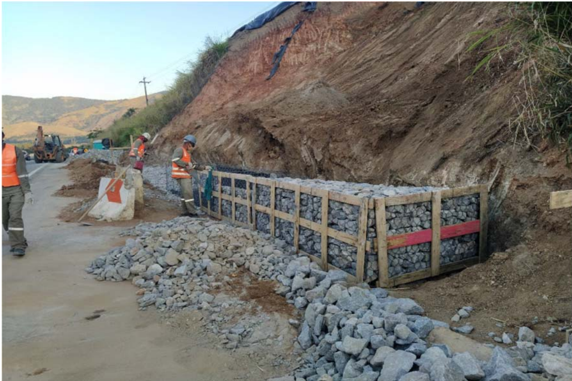
FOTO 22 – Obra de recuperação do Talude Km 9+760 – F1
