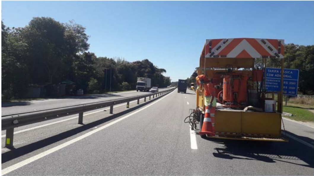
FOTO 01 – Pintura de faixas - KM 20+500 Norte - F1
