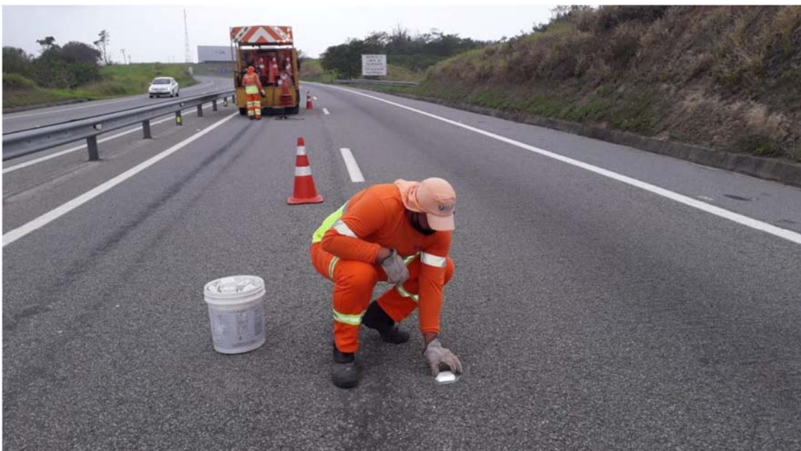
FOTO 08 - Implantação de Tachas - Km 43+000 Norte - F2
