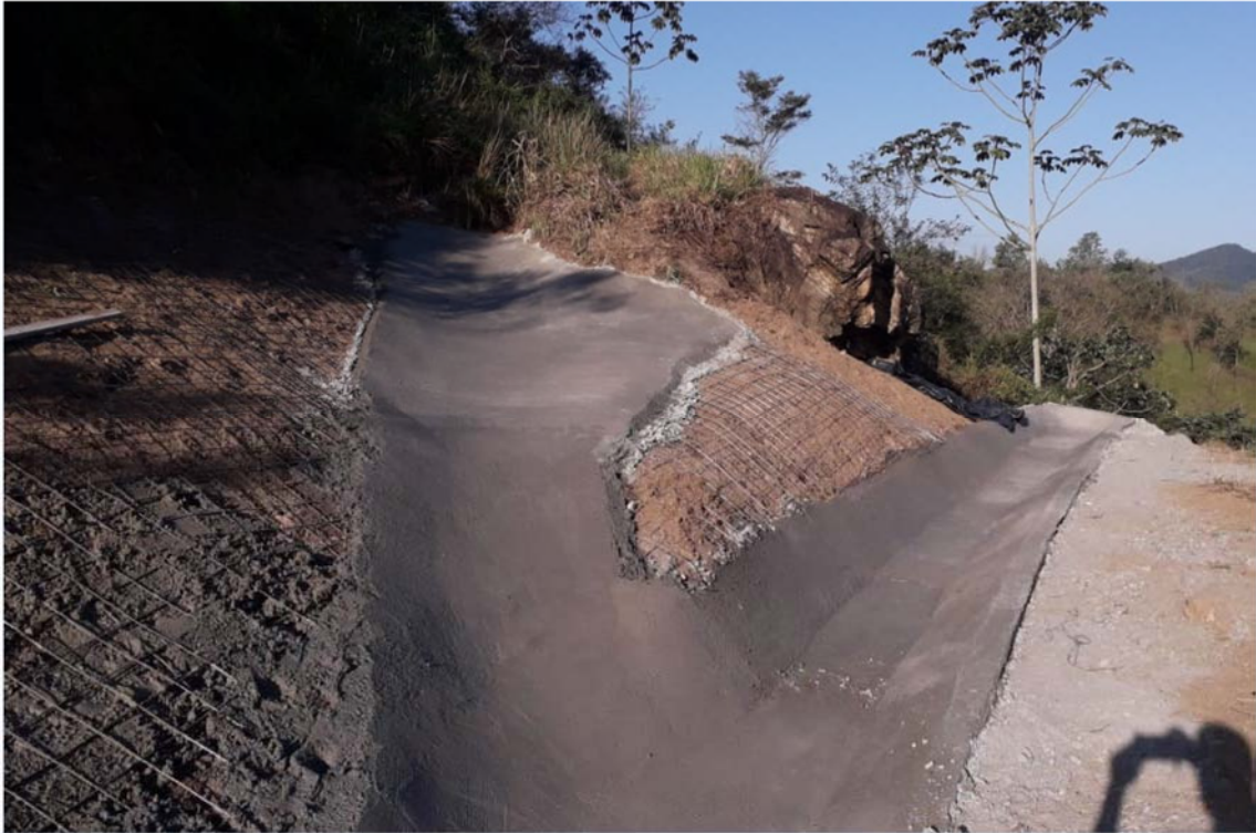
FOTO 18 – Drenagem Talude Km 15,7 – F2
