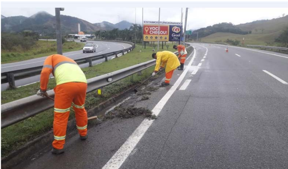
FOTO 15 - Limpeza de sarjeta - Km 23+000 Sul - F1
