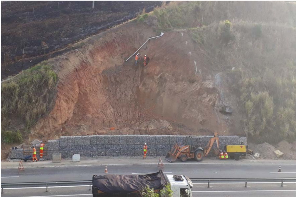
FOTO 24 – Obra de recuperação do Talude Km 9+760 – F3
