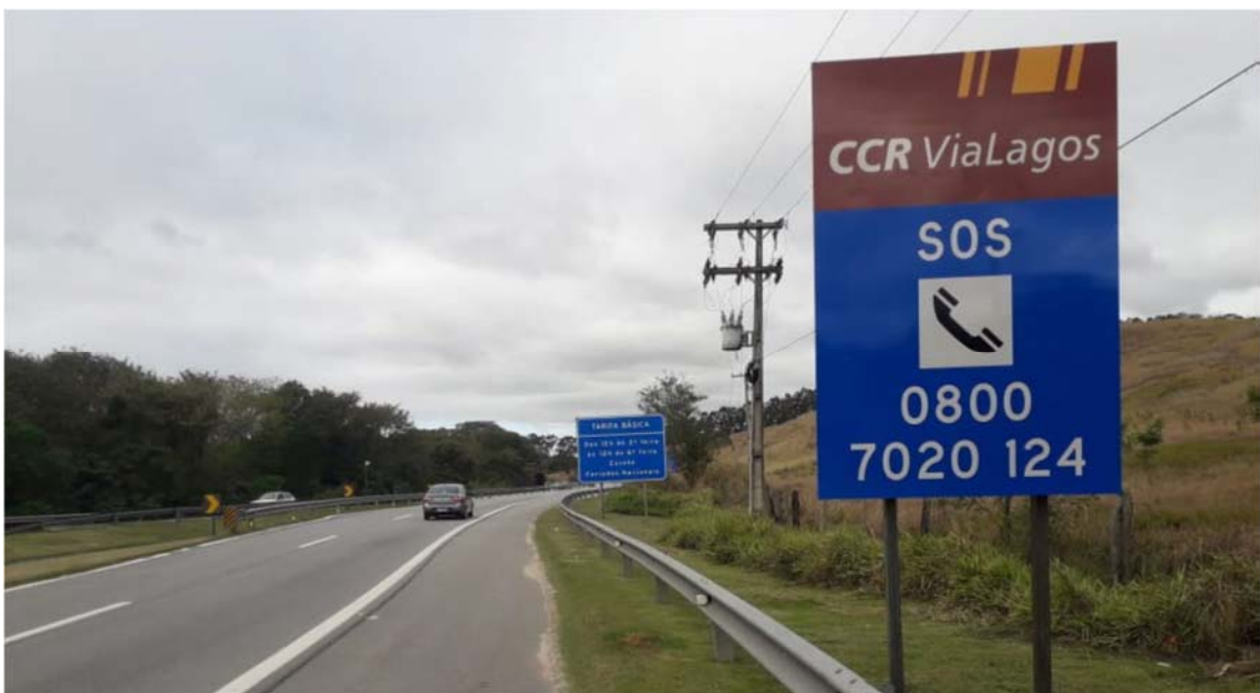
FOTO 04 - Substituição de Placa - Km 21+500 Norte - F2
