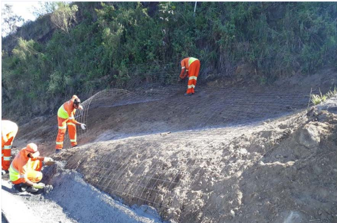
FOTO 17 – Drenagem Talude Km 15,7 - F1
